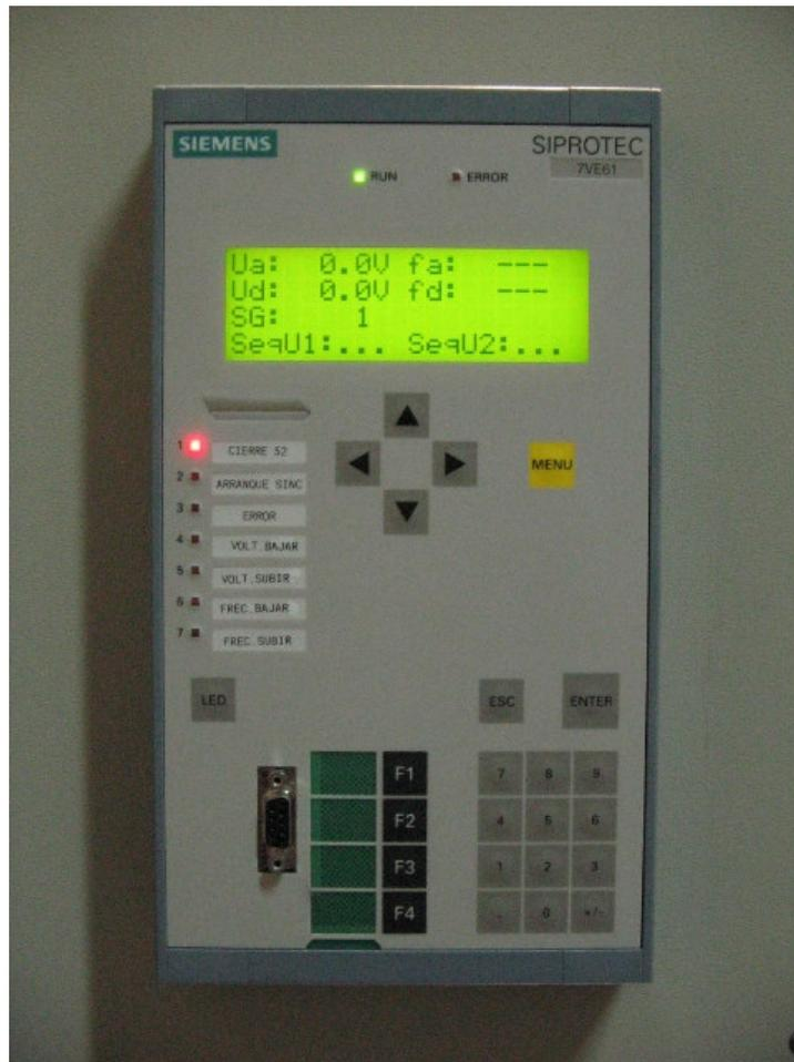
*Relé digital, para sincronización de generador (SIPROTEC- SIEMENS)*
